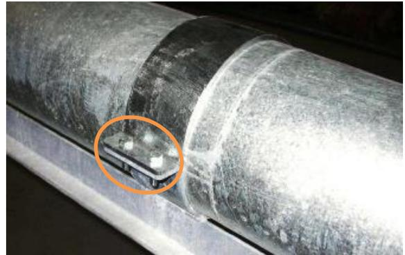
**Etape 3** | Fixer les montants au coulisseau à l'aide de 2 écrous de verrouillage et 2 rondelles plates Ø20. Pour faciliter l'installation, l'utilisation d'une pince grip ou d'un serre joint peut-être recommandé.
